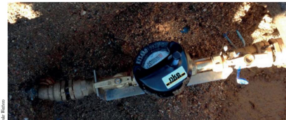
**Composé d'une tête de relève de compteur d'eau et d'un capteur, le système Sens'O™ de nke Watteco a la particularité d'être le premier module radio de télérelève doté de la technologie de communication radio sécurisée et bidirectionnelle LoRa.**
